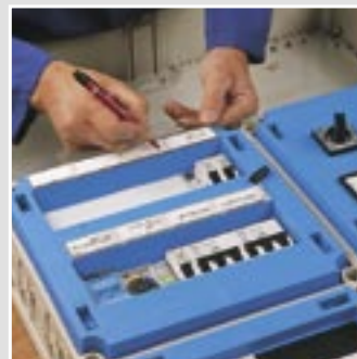
1.7 Stromkreiskennzeichnung
