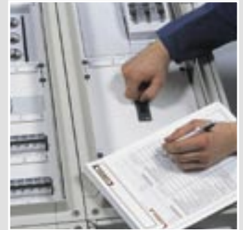
1.1 Prüfung der Funktionstüchtigkeit von Betätigungselementen: z.B. Taster, Schalterantriebe, Türen, Klappen
