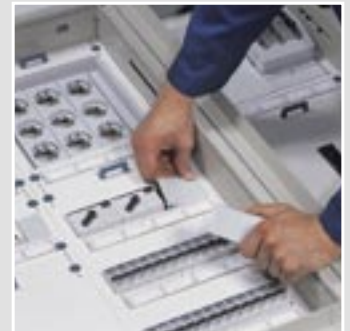
1.1 Prüfung der Funktionstüchtigkeit von Betätigungselementen: z.B. Taster, Schalterantriebe, Türen, Klappen
