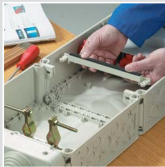
Последующая установка верхнего ребра бокса.
