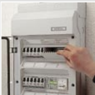
12 bis 54 Teilungseinheiten: Abdeckstreifen für den Geräteausschnitt beigelegt
