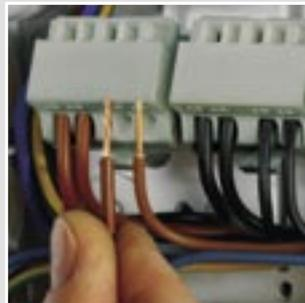
Unterschiedliche Leiterarten - massive (r) und flexible (f) Leiter - werden in einer Klemme verbunden.
