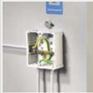
Anschlusskasten für Potenzial-Ausgleichleitungen
