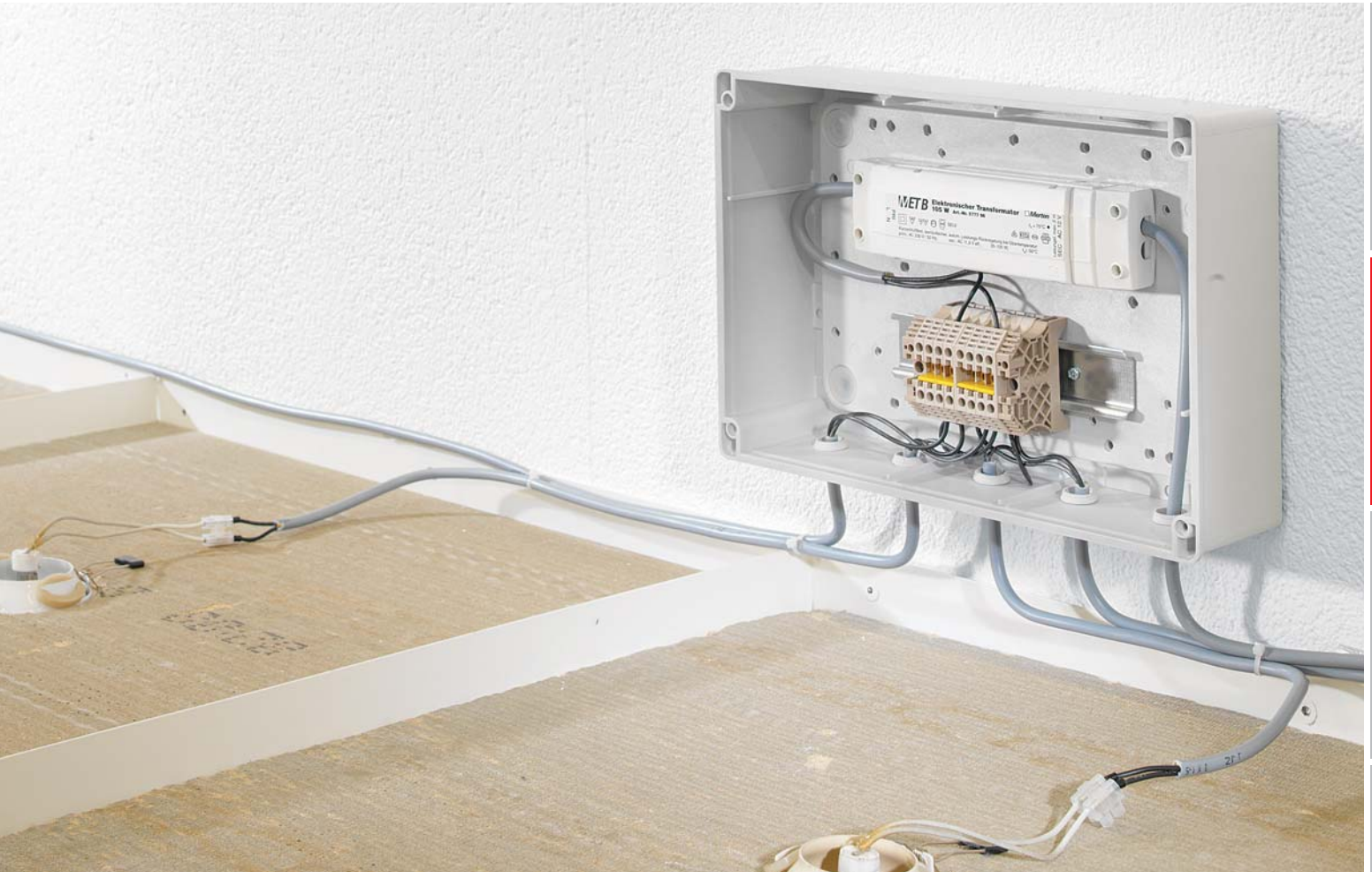
Кабельный ввод может быть просверлен индивидуально.
