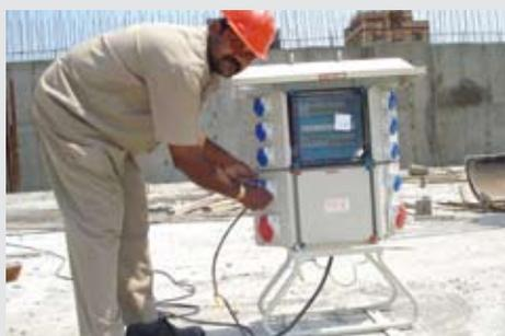
**Изделие:** Модульный распределительный щит **MI** для строительства **ENYMOD**
