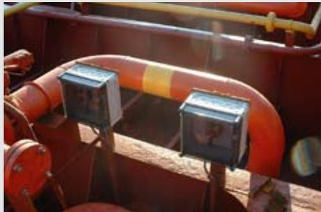
Прочный корпус из поликарбоната со степенью защиты IP 65: пыле и влагонепроницаемость. Высокая прочность против ударных нагрузок (IK 08) устойчивость к коррозии и УФ-излучению. Корпус с защитной изоляцией
