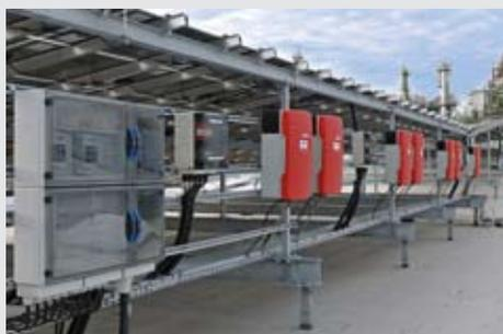
**Изделия:** Распределительный щит **ENYSUN** для монтажа фотоэлектрических ячеек, распределительный щит **ENYSTAR**, низковольтное распределительное устройство **ENYPOWER**
