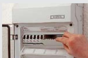
От 12 до 54 мод.: для закрытия неиспользуемых проемов прилагается заглушка
