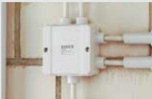
**Кабельный ввод через метрические выбиваемые отверстия**
