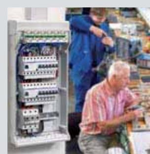
Соответствует новым нормам IEC 60 364-4-41: распределительный щит для малоамперных цепей KV, имеющий до четырех разъемных N-потенциалов в однойшине, позволяет устанавливать УЗО без дополнительных усилий и приспособлений.
