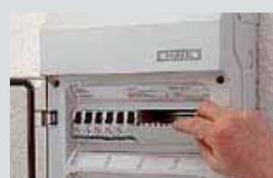
От 12 до 54 мод.: для закрытия неиспользуемых проемов прилагается заглушка
