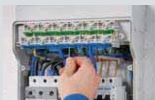
FIXCONNECT®: клеммная технология для проводов PE и N
