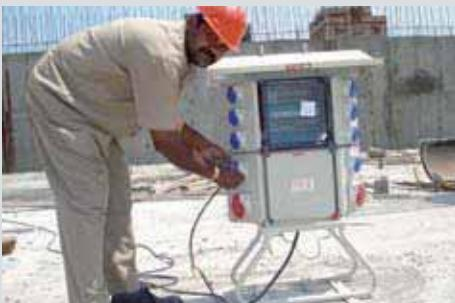
**Изделие:** Модульный распределительный щит Mi для строительства **ЕНУMOD**
