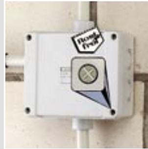
Edelstahlschrauben V2A mit metrischem Schnellgewinde.
