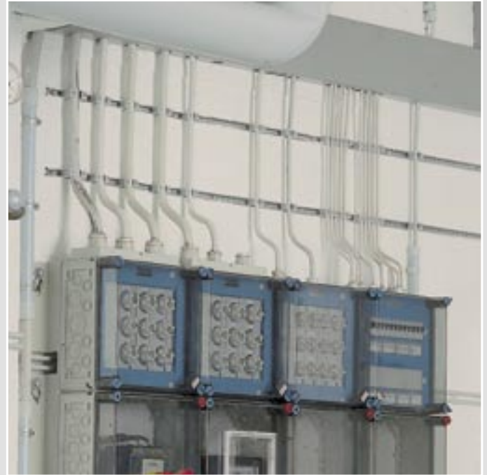
Abdeckung der Kabeleinführung mit Rangier-Kanal.
