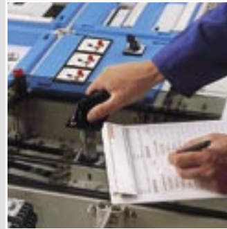
1.1 Prüfung der Funktionstüchtigkeit von Betätigungselementen: z.B. Taster, Schalterantriebe, Türen, Klappen
