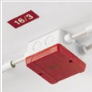
Kabelabzweigkästen für Stromkreise der Sicherheitsbeleuchtung mit rotem Deckel.
