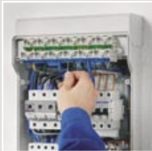
FIXCONNECT®-Steckklemmenteknik für PE und N
