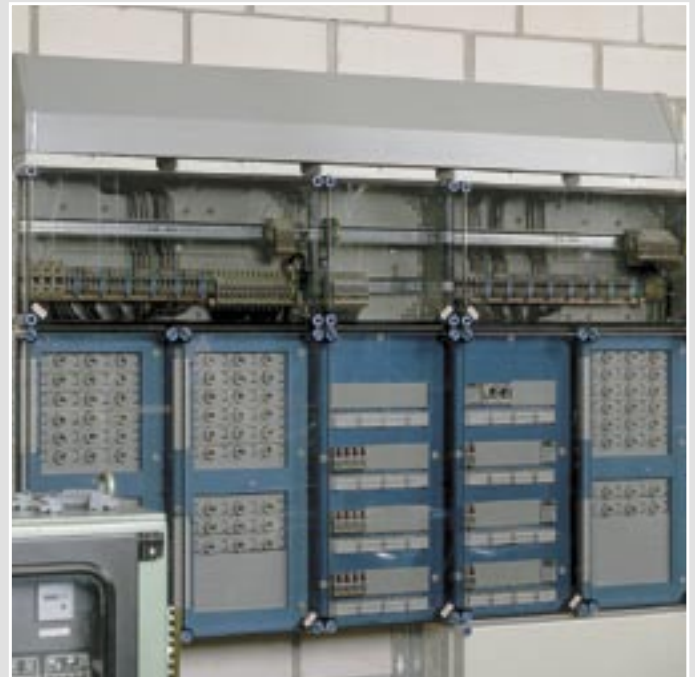
Abdeckung der Kabeleinführung mit Rangier-Kanal.
